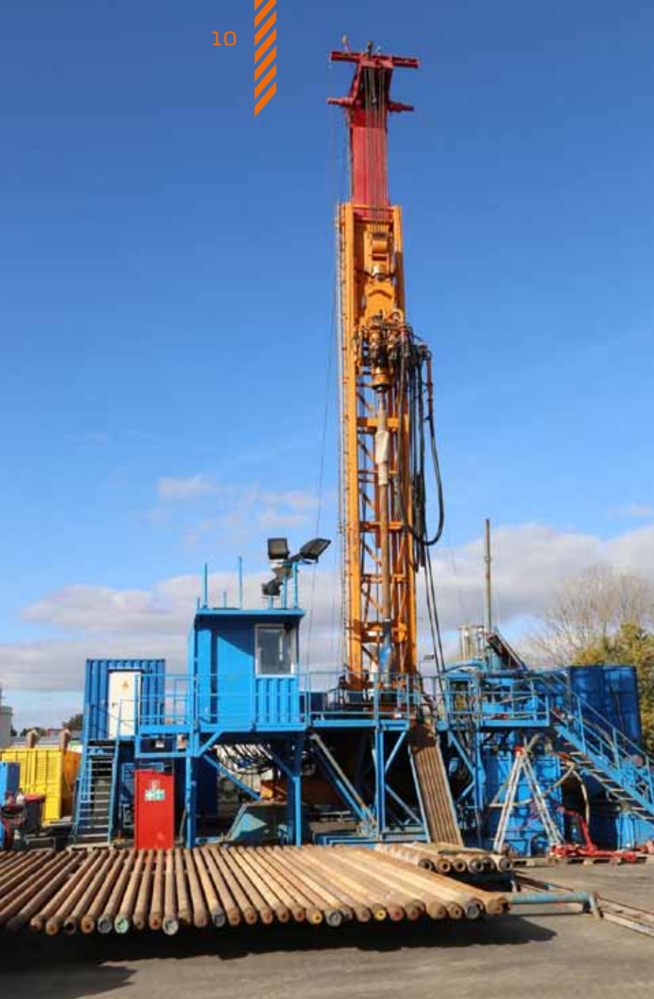
▲ Blick auf die Bohranlage (Foto: K. Obst, LUNG M-V)
